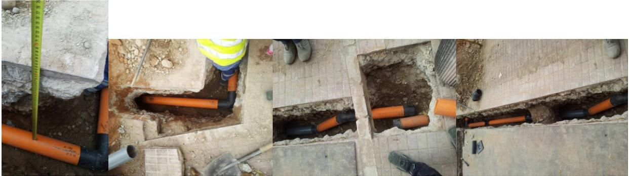
5.- Visita a la obra donde se observa la soldadura con acometida de la cafetería adyacente así como la protección con “remaline” por cruce con varios servicios. Se observan diferentes herramientas de trabajo, manuales y eléctricas.
