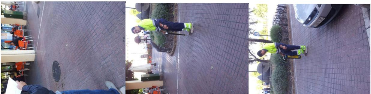
3.- Visita a la obra en la realización de una cata junto al religue, así como la apertura de zanja. Se observa que la red existente sale a menos de 60 cm. Se observan algunos Equipos de Protección Individual (EPIs) como casco de seguridad, guantes y chaleco reflectante, así como medidas de protección colectiva como las vallas perimetrales. También se observa la señalización de seguridad en la calzada.
