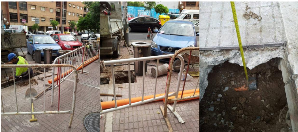
4.- Visita a la obra en la fase de colocación de tubería. Posterior visto bueno de los 6 m de PE 110
