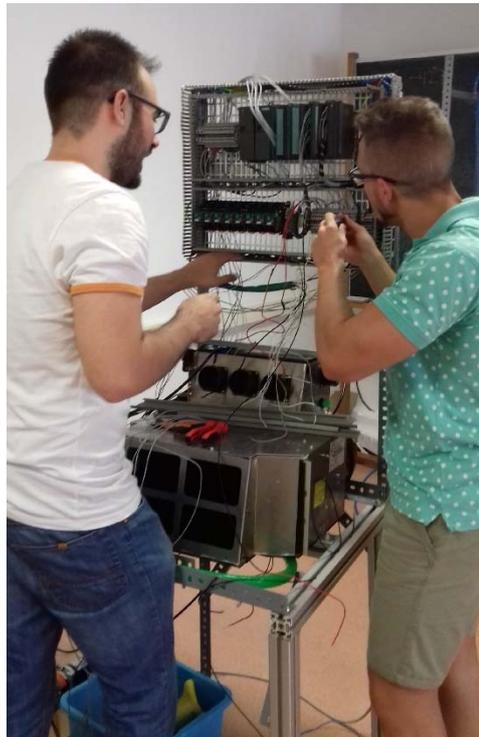
Figura 4 – Cableado del cuadro eléctrico
