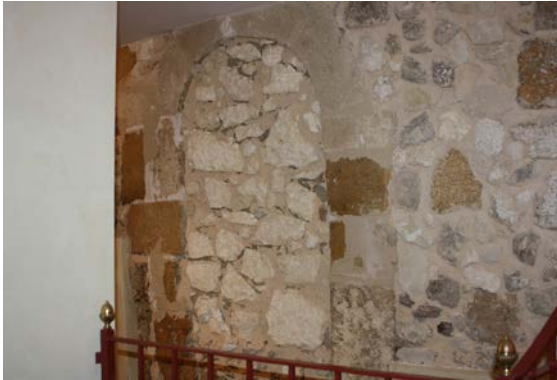
Fig.18. Aperture preesistenti oggi murate e rimesse in vista. Foto: (M.M.)
