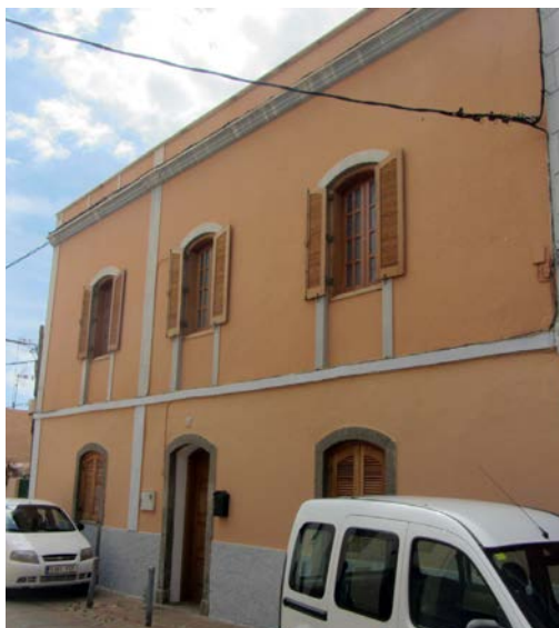
Fig. 3. Fachada con sustitución de elementos originales por otros de similares características. Ingenio (Canarias). Foto: Eduardo Martín del Toro.
