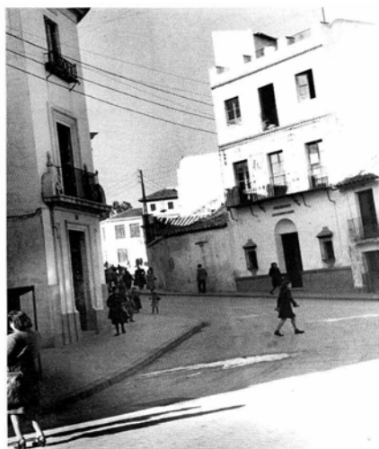
Fig. 6. Fotografía de la fachada del Cine El Rinconcito antes de su demolición en 1963. Extraída de Fina Zacarias en el grupo "Córdoba Antigua España".
