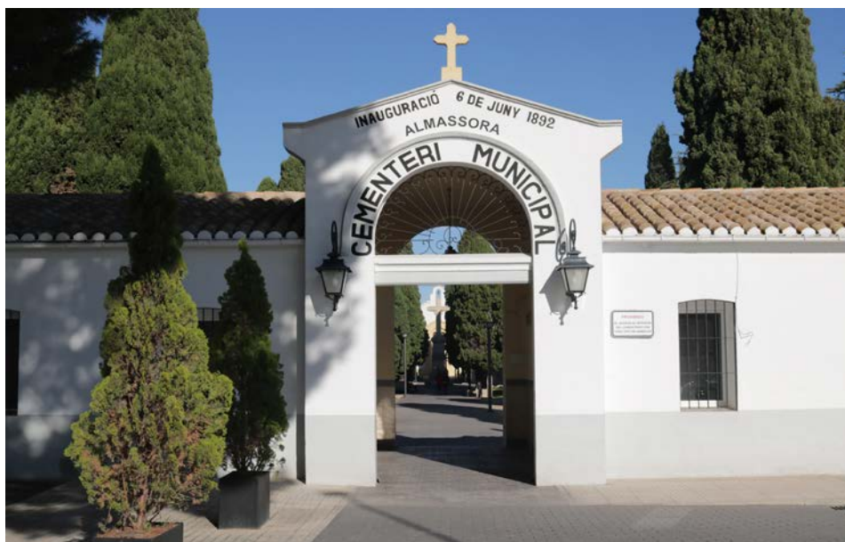
Fig. 3. Fachada del cementerio de Almassora de Francisco Tomás. Imagen de la autora.
