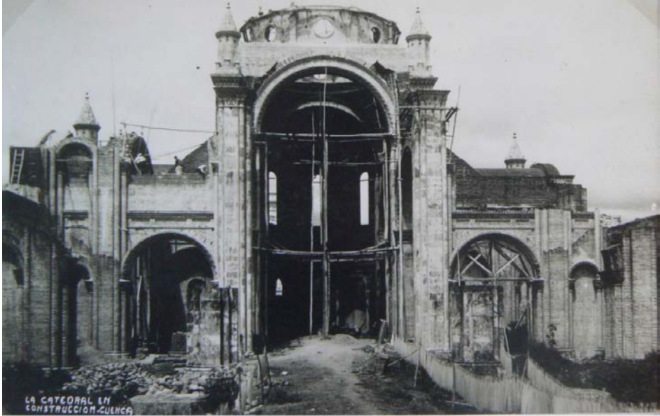
Fig. 2. La Catedral de Cuenca en construcción. Fuente: INPC - Archivo fotográfico Dr. Miguel Díaz Cueva..
