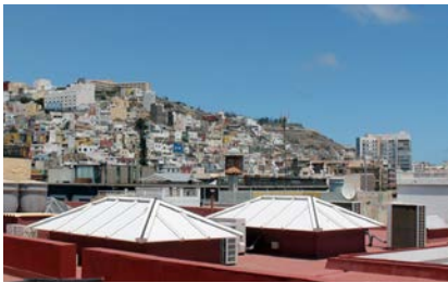
Fig. 7. Patio cubierto y sistemas mecánicos de acondicionamiento. Vegueta (Canarias). Foto: Juan Carmelo Arjona Montesdeoca.
