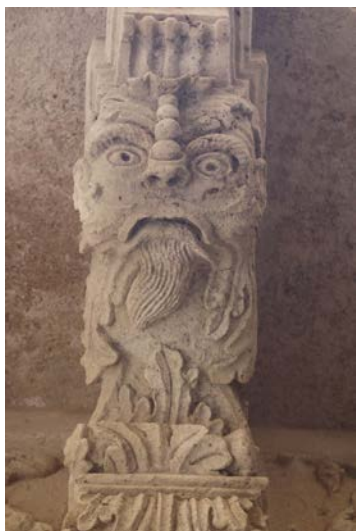
Fig. 3. Mascherone nel balcone laterale sinistro. Foto: (M.M.)
