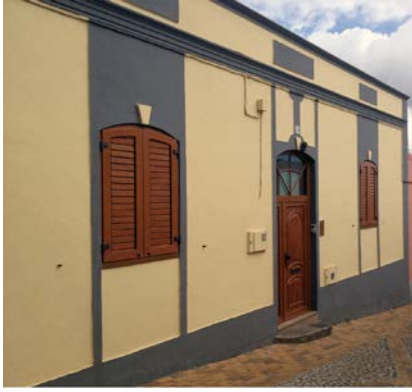
Fig. 5. Fachada donde se ha sustituido la carpintería original de madera por aluminio. Ingenio (Canarias). Foto: Eduardo Martín del Toro.
