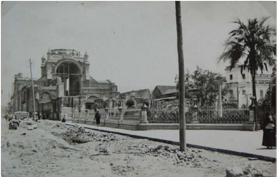
Fig. 3. La Catedral en construcción. Fuente: INPC - Archivo fotográfico Dr. Miguel Díaz Cueva.
